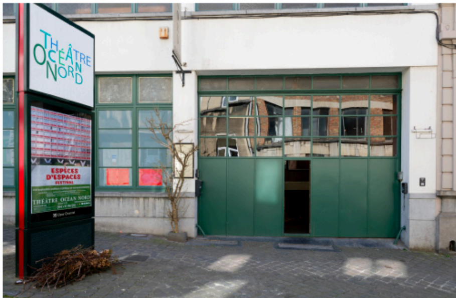
La façade du Théâtre Océan Nord, soit les anciens garages Saint-Hubert, de style moderniste, rue Vandeweyer à Schaerbeek. La porte est trop étroite pour la réglementation actuelle.
